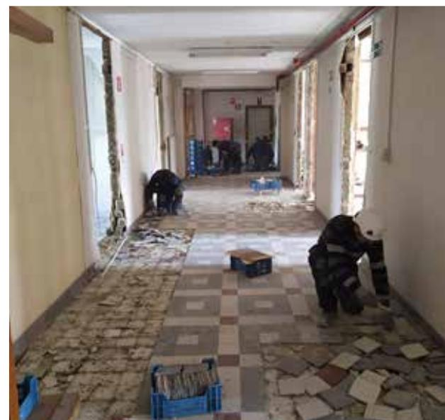
Rückgewinnung von hydraulischem Estrich bei einem Abbruch. Quelle: Rotordc [www.rotordc.com](http://www.rotordc.com)
